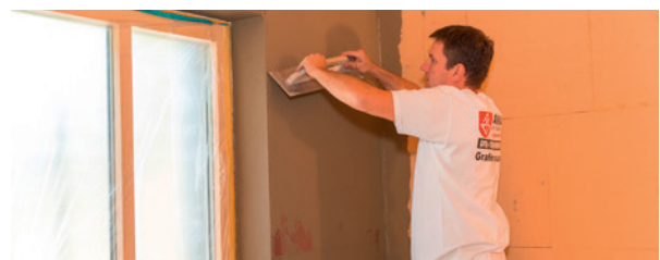
Wapeningsnet minimum 10 cm overlappen baan op baan, lichtjes indrukken en een dunne laag overheen zetten.
