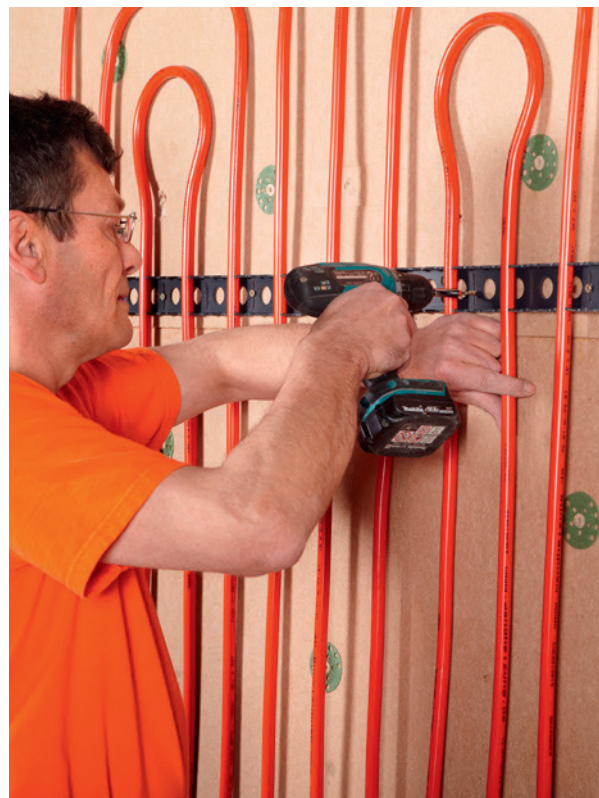
Klima raster op de isolatieplaten schroeven.
