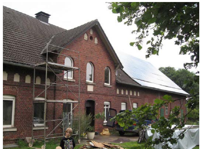
Abb. 8. Bauernhof während der Sanierung.
